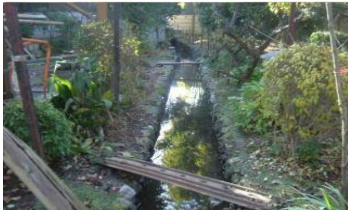
▲8代目中野久次郎は熊野神社に寄進し、水路全般および石垣等、土木整備された
